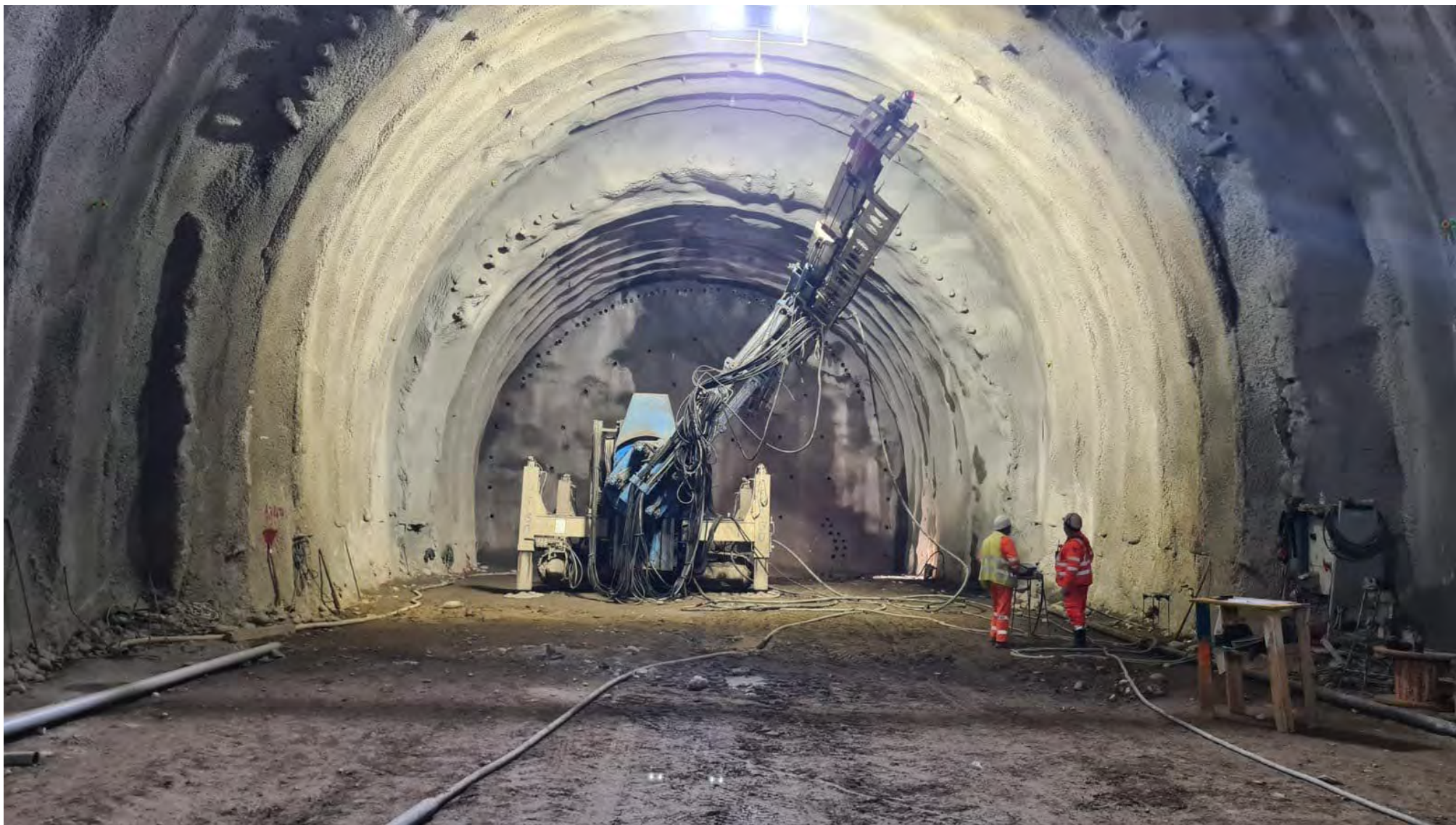
Scavo sotto gli edifici
